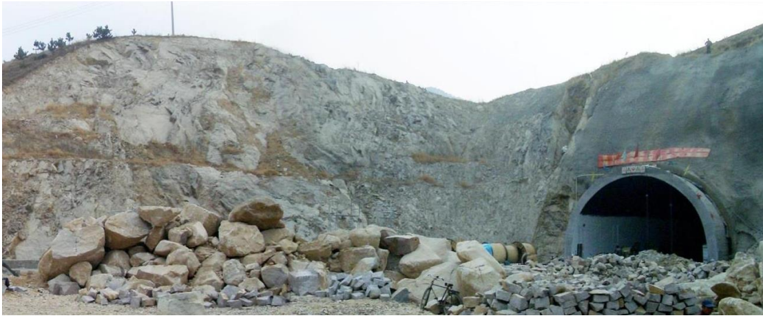
硬质岩石边坡（山东青岛，微风化、裂隙不发育裸岩边坡）
