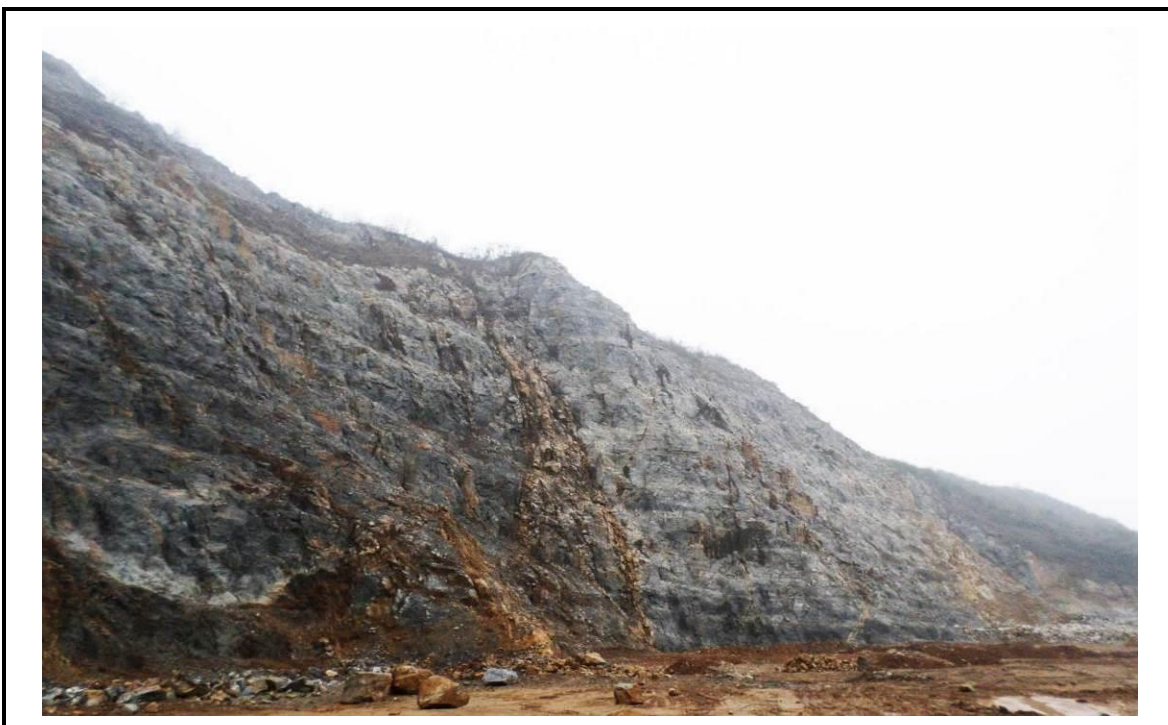
高陡硬质岩石坡面（河南新乡，混凝土坡面）
