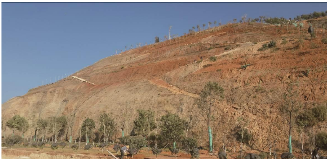
软质岩石矿山（云南大理，粉砂质泥岩、强风化、遇水易崩塌）
