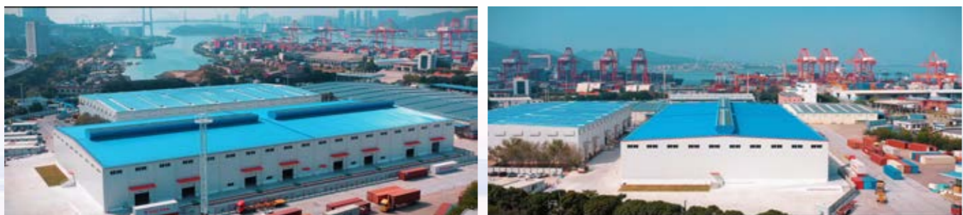
厦门象屿综保区5号仓库
